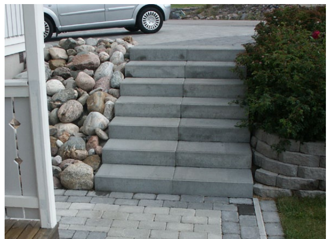
Trappa med Benders Blocksteg.
