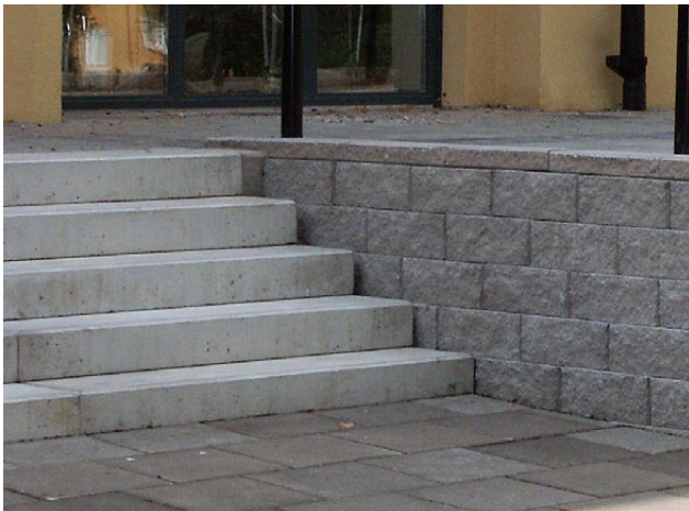
Trappa med Benders Blocksteg vid Benders Megastone mur.
