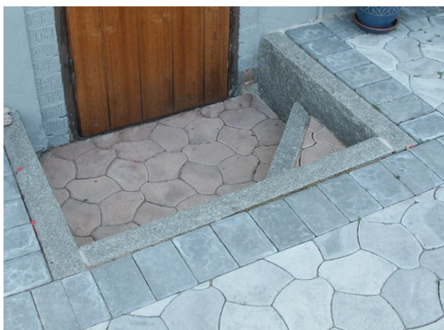
Trappa med granit och Bender Pompeji.
