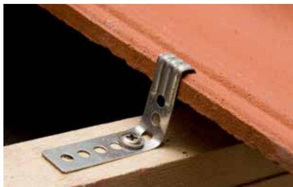
Montering av Takfotsklammer
